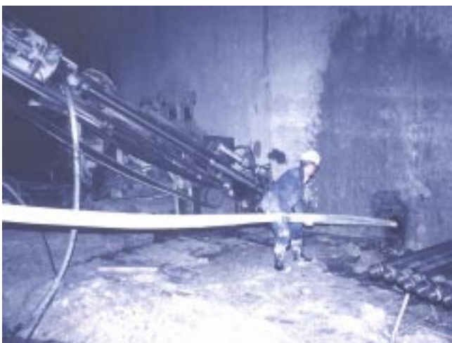
Mise en place du tirant
