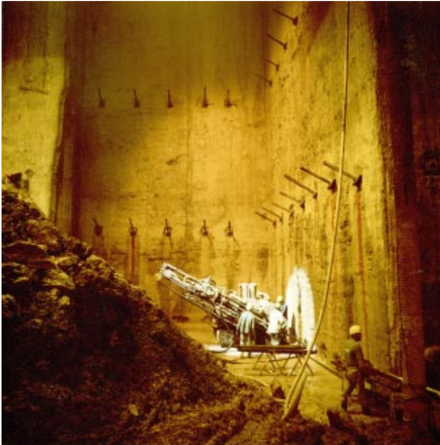
Forage pour tirants
