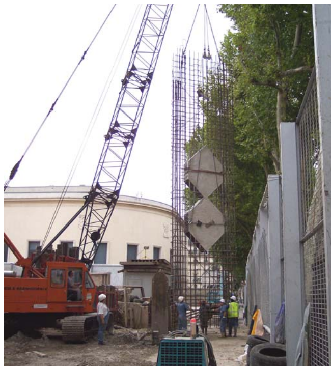
Le passage du tunnelier pour réaliser les canalisations de prise d'eau à partir du bac de pompage a nécessité la mise en place dans les cages d'armatures de paroi moulée de réservations constituées de boîtes métalliques remplies de coulis de ciment
