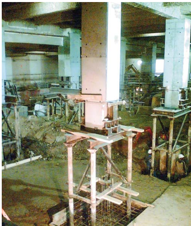
Micropieux de reprise de poteaux
