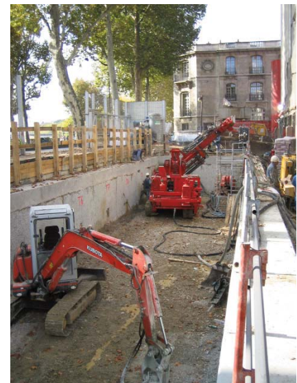
Terrassement et tirants d'ancrage
