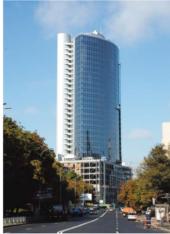
La tour terminée
