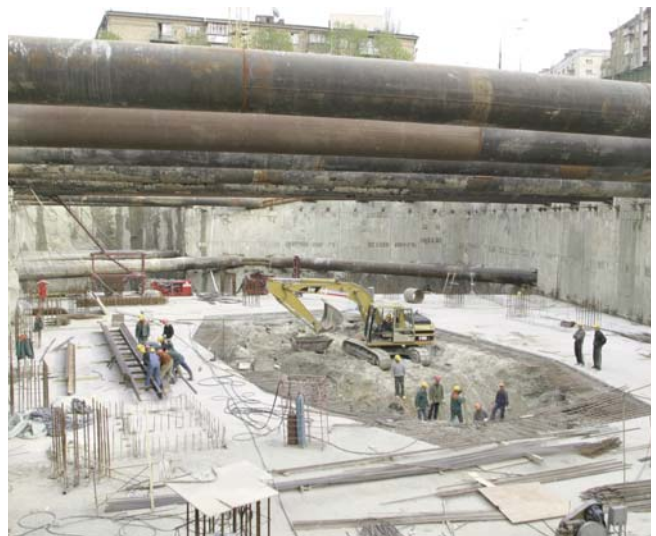
La dalle annulaire sous les butons
