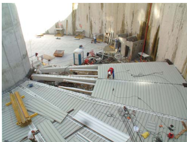
Exécution des planchers hélicoïdaux
