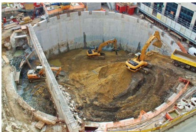
Terrassement à ciel ouvert avec construction en parallèle du bâtiment d'accueil
